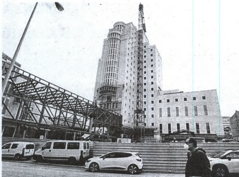
La Xunta permitirá a los vigueses visitar la torre del antiguo Xeral mientras duren las obras.
